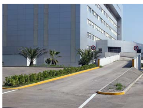
Rampa di accesso al Pronto Soccorso
