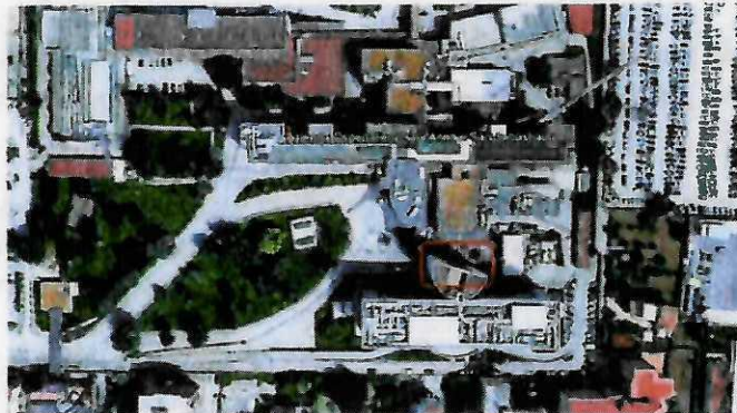
Figura 1 - Vista aerea di parte del complesso ospedaliero di "Sant'Anna e San Sebastiano" e identificazione dell'area di intervento
