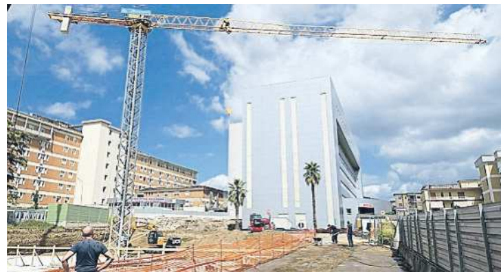
I lavori alla nuova palazzina dell’ospedale di Caserta
